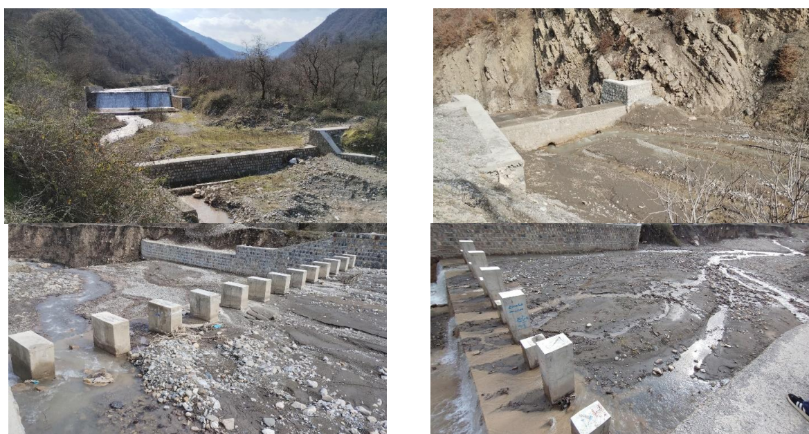
شکل ۷- تصاویر برخی از سازه‌های آبخیزداری اجراشده در سطح حوزه آبخیز محمدآباد
